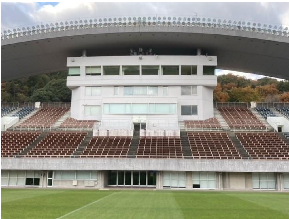
④ 広島広域公園第一球技場 スタンド
